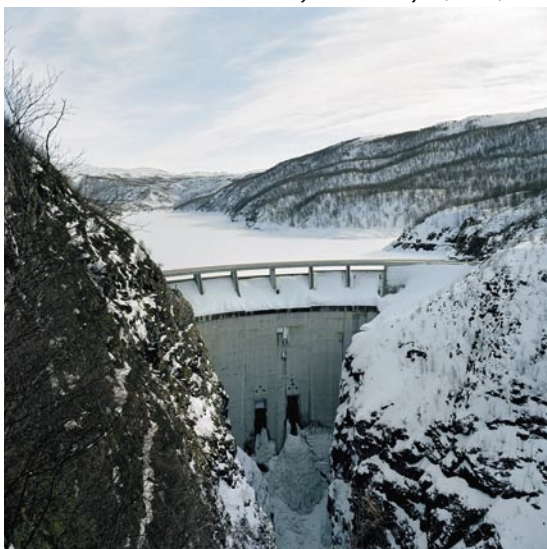
Foutu barrage d'Alta, Máze, 2005
